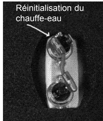
Figure 5 : Réinitialisation du chauffe-eau
