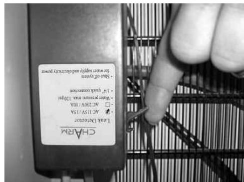
Branchez l'appareil dans une prise de 120V. Pour le **Max Plus** avec système UV installé, vérifiez que la pompe soit amorcée tel que discuté à la page 2 de ce guide. Allumez les interrupteurs pour l'eau chaude et l'eau froide.
