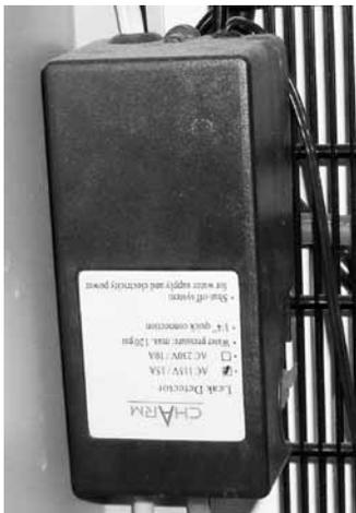
Le plancher du cabinet comprend une gouttière intégrée qui accumule toute eau qui s'y fuit. Il se trouve deux (2) sondes au fond de la gouttière qui sont raccordés au détecteur de fuite. Si les sondes détectent de l'eau dans la gouttière, elles envoient un signal au détecteur de fuites qui fait automatiquement couper l'alimentation d'eau à votre distributrice **Max** ou **Max Plus**.
